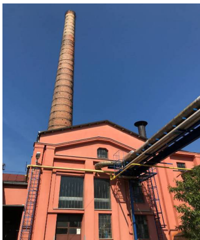
Pročelje najstarije kotlovnice u Industrijskoj zoni
