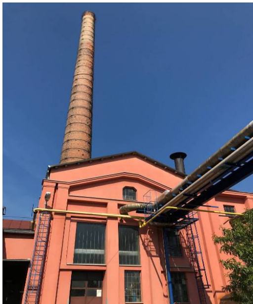
Pročelje najstarije kotlovnice u Industrijskoj zoni
