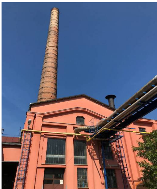
Pročelje najstarije kotlovnice u Industrijskoj zoni
