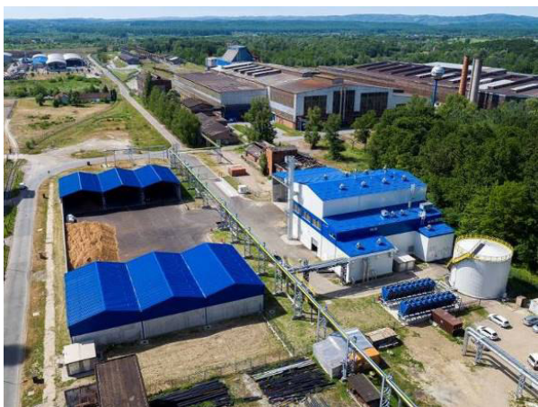
Kogeneracijsko postrojenje BE-TO Sisak
