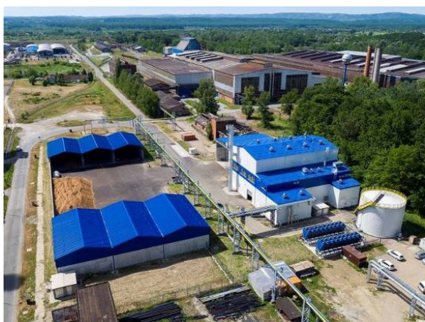
Kogeneracijsko postrojenje BE-TO Sisak
